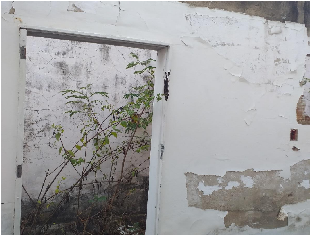
FOTO 20 – Área Posterior ao restaurante para demolição.
