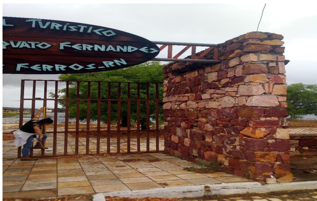
Foto 02: Fachada frontal/ Pórtico
