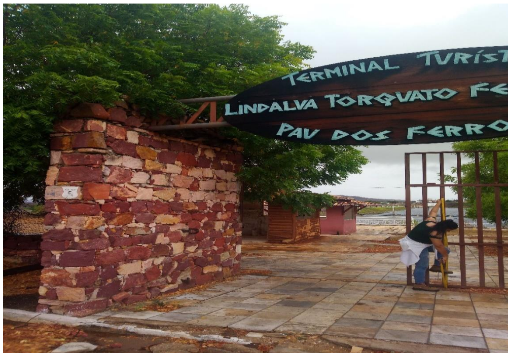
Foto 01: Fachada frontal/ Pórtico
