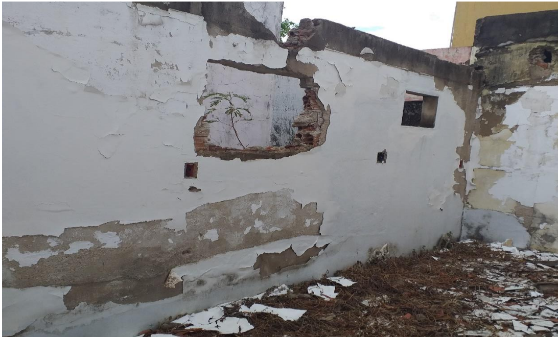
FOTO 18 – Área Posterior ao restaurante para demolição.
