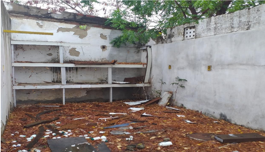
FOTO 19 – Área Posterior ao restaurante para demolição.
