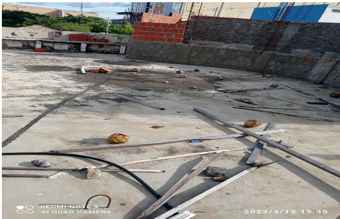
FOTO 11 – Laje Superior / Piso para manutenção
