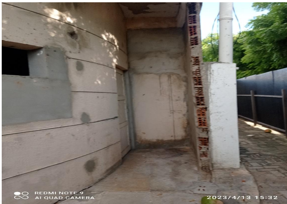
Foto 04 – Acesso ao banheiro / Circulação
