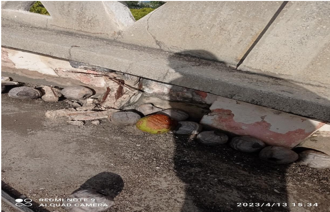
FOTO 12 – Laje Superior / Bancos para Restauração
