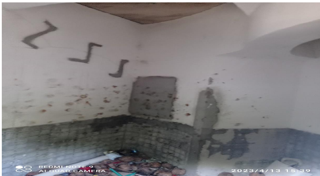
FOTO 06 – Fotos internas dos Banheiros
