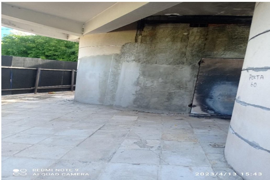
Foto 01: Fachada frontal/ Pórtico
