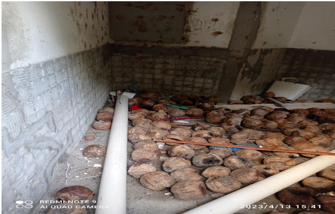
FOTO 07 – Fotos internas dos Banheiros
