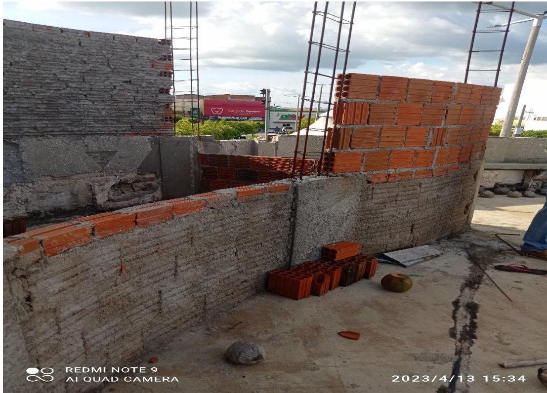
FOTO 10 – Alvenaria existente a demolir
