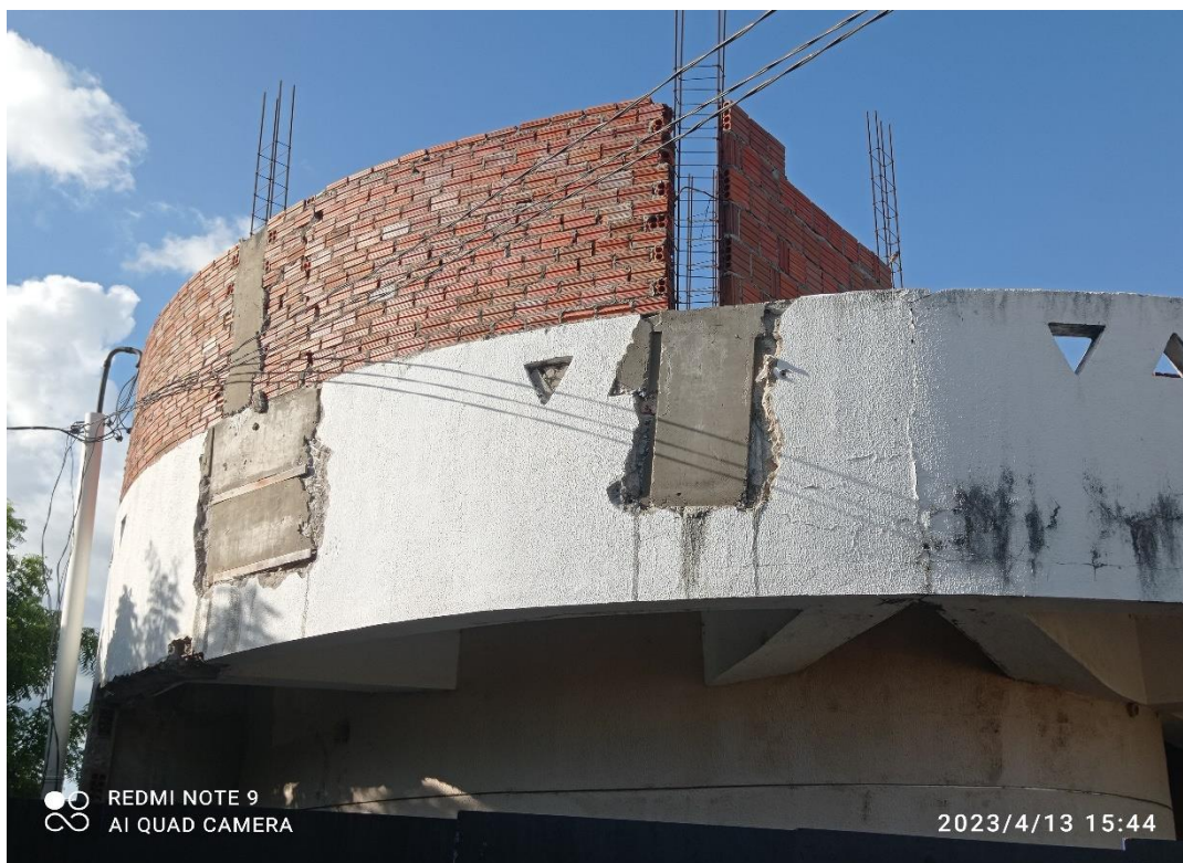
FOTO 13 – Laje Superior / Alvenaria para demolição
