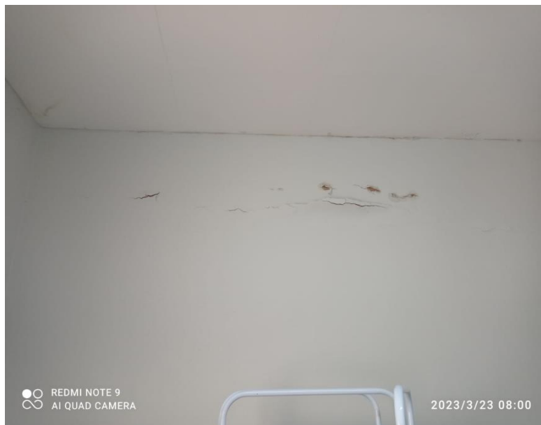
FOTO 05 – Área do reservatório / Sala de enfermagem
