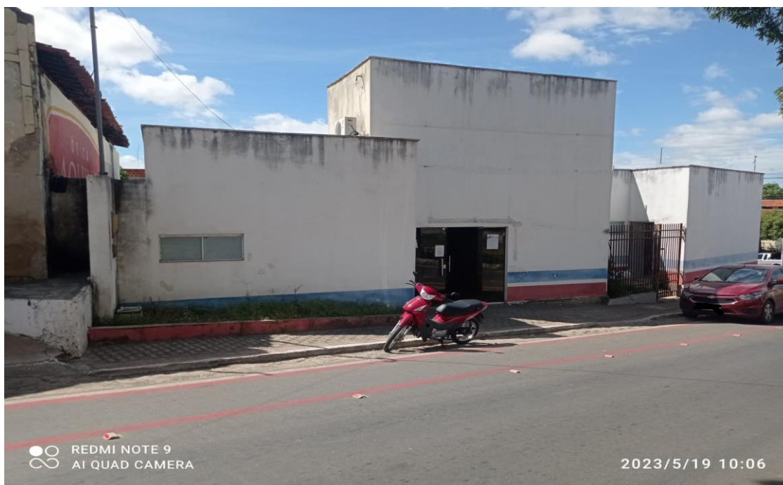
Foto 01: Fachada frontal/ Pórtico
