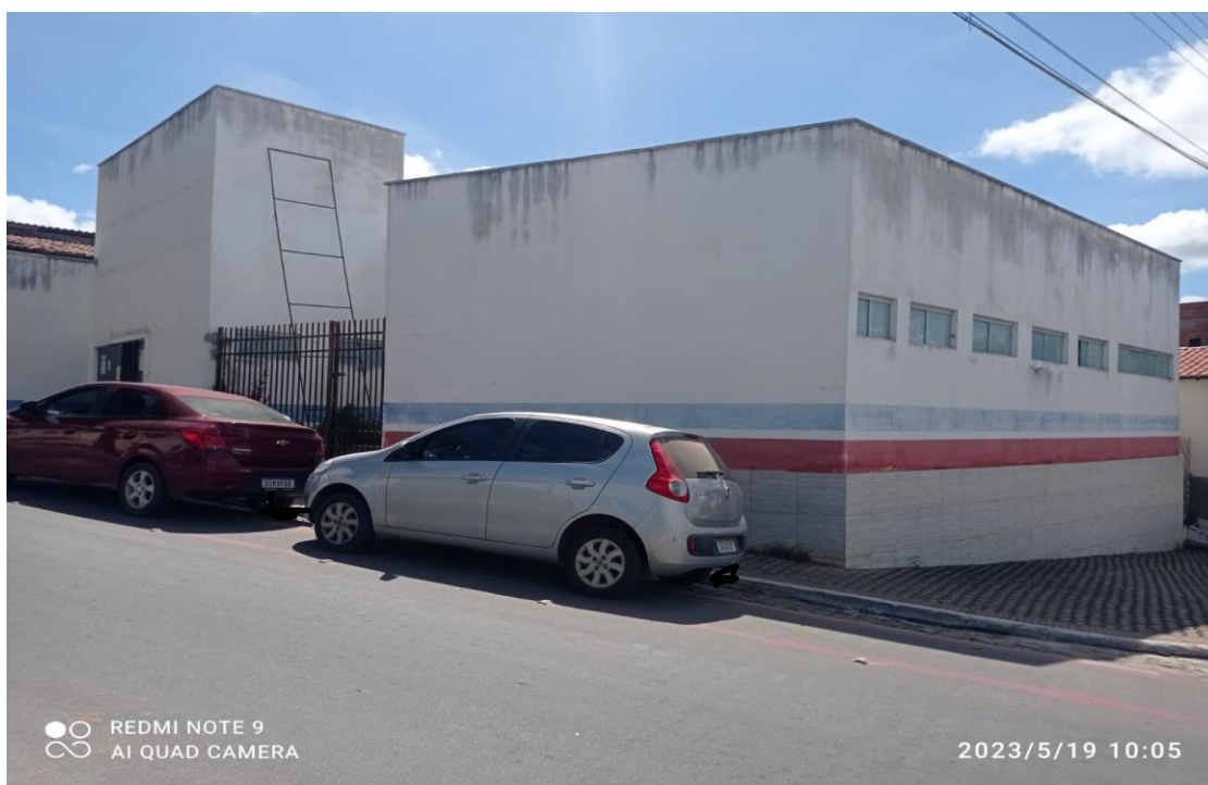
Foto 02: Fachada frontal/ Pórtico
