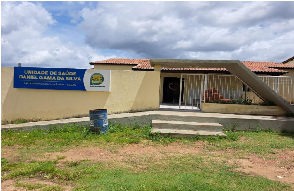
Foto 01: Fachada frontal/ Pórtico
