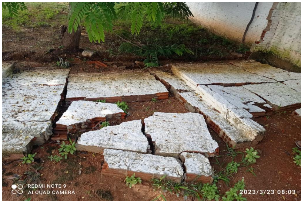
FOTO 09 – Muro divisório – lado oeste.
