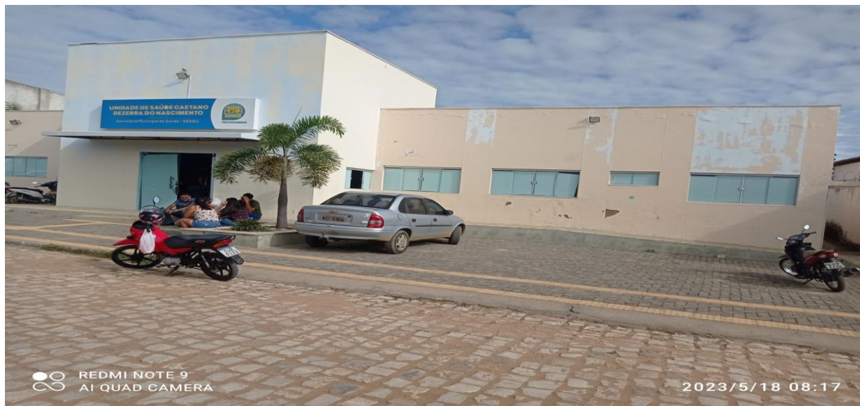
Foto 01: Fachada frontal/ Pórtico
