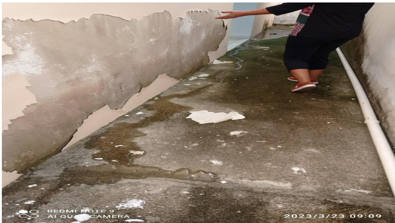
Foto 07 – Parte Lateral / Externa.
