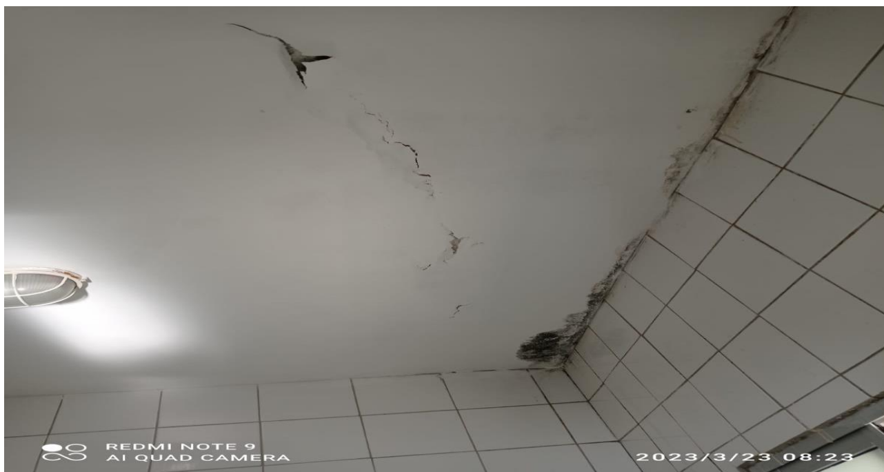
Foto 02 – Cozinha/ Área de Serviço
