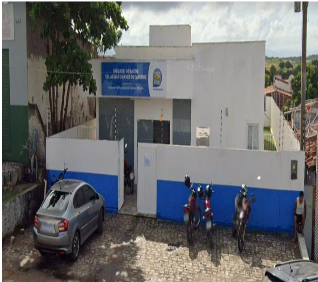
Foto 01: Fachada frontal/ Pórtico
