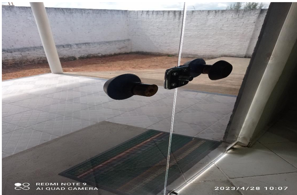
FOTO 14 – Reposição ferragens em Porta de Vidro
