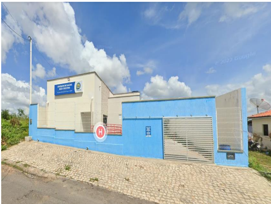
Foto 01: Fachada frontal/ Pórtico
