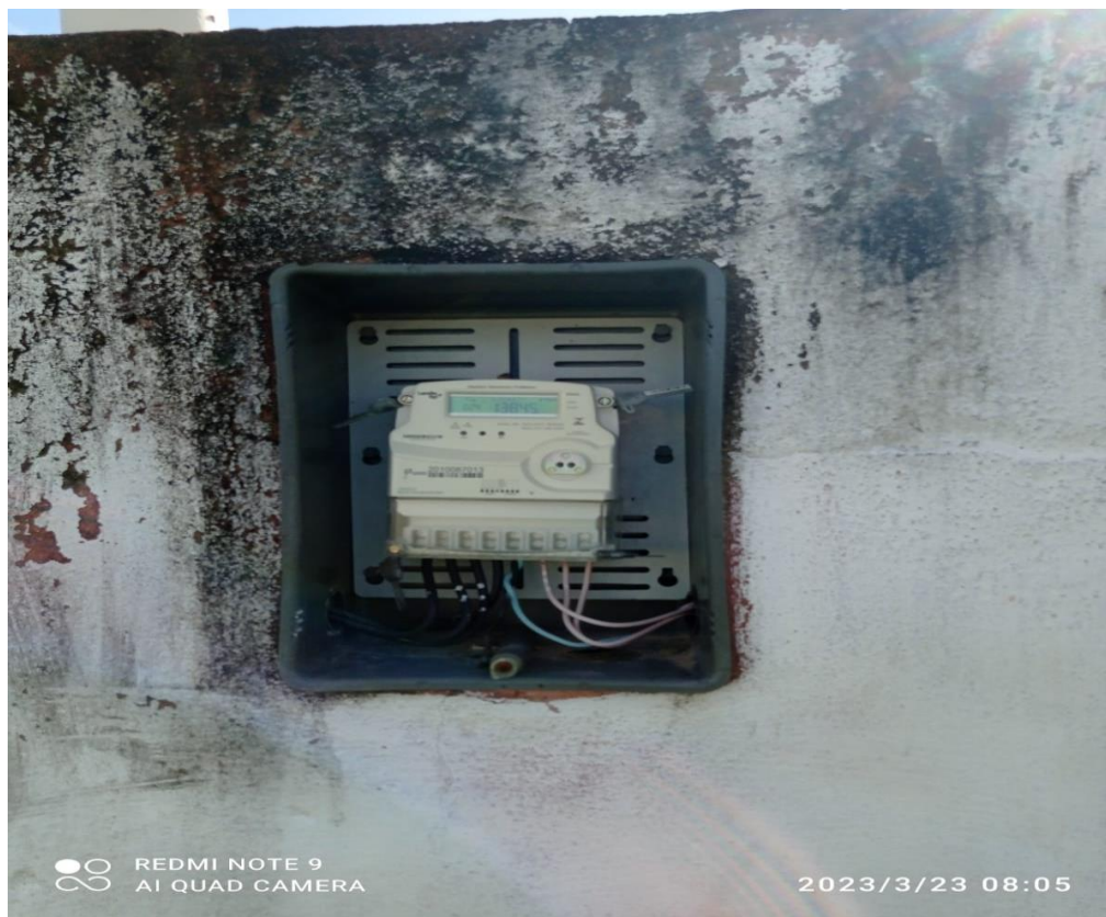
FOTO 11 – Muro divisório – lado oeste.
