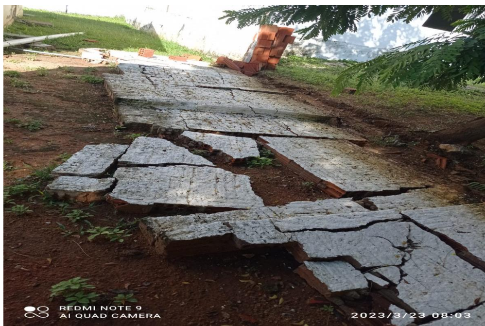
FOTO 10 – Muro divisório – lado oeste.
