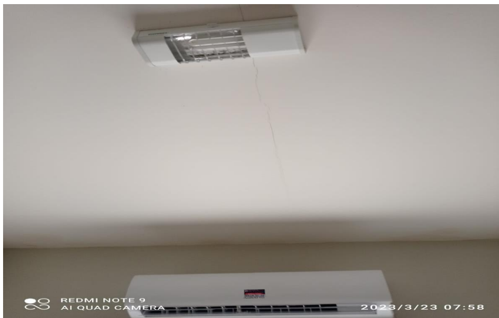
FOTO 12 – Reposição de Iluminarias com mais eficiência
