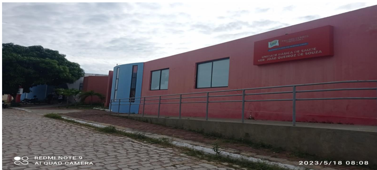
Foto 01: Fachada frontal/ Pórtico
