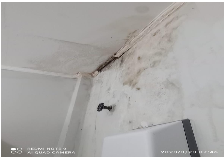
Foto 02 – Sala de Preparo de Materiais
