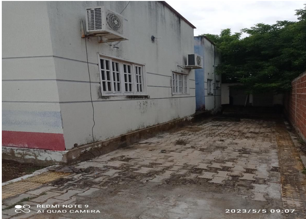
Foto 09 – Parede Externa Lado Esquerdo
