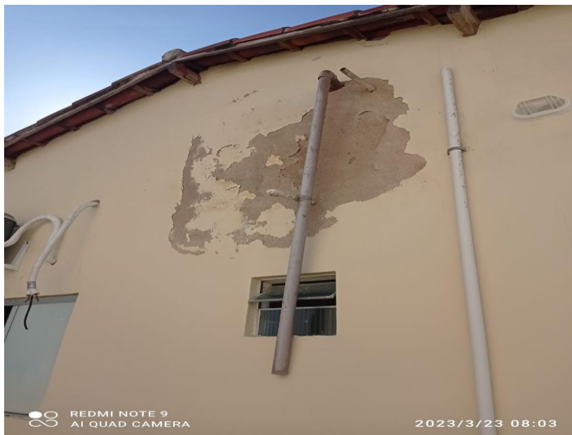
FOTO 04 – Área do reservatório / externo
