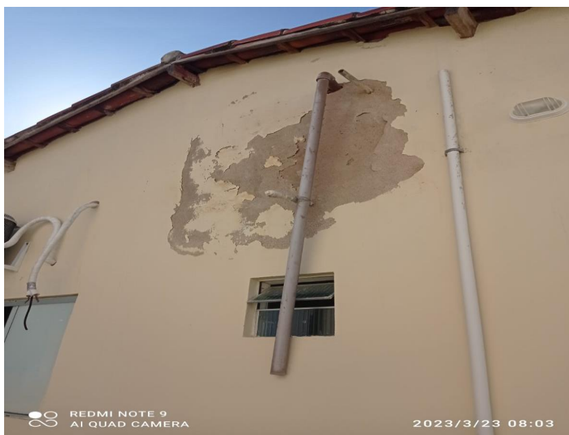
FOTO 04 – Área do reservatório / externo
