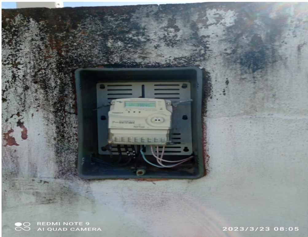
FOTO 11 – Reposição do Quadro Elétrico
