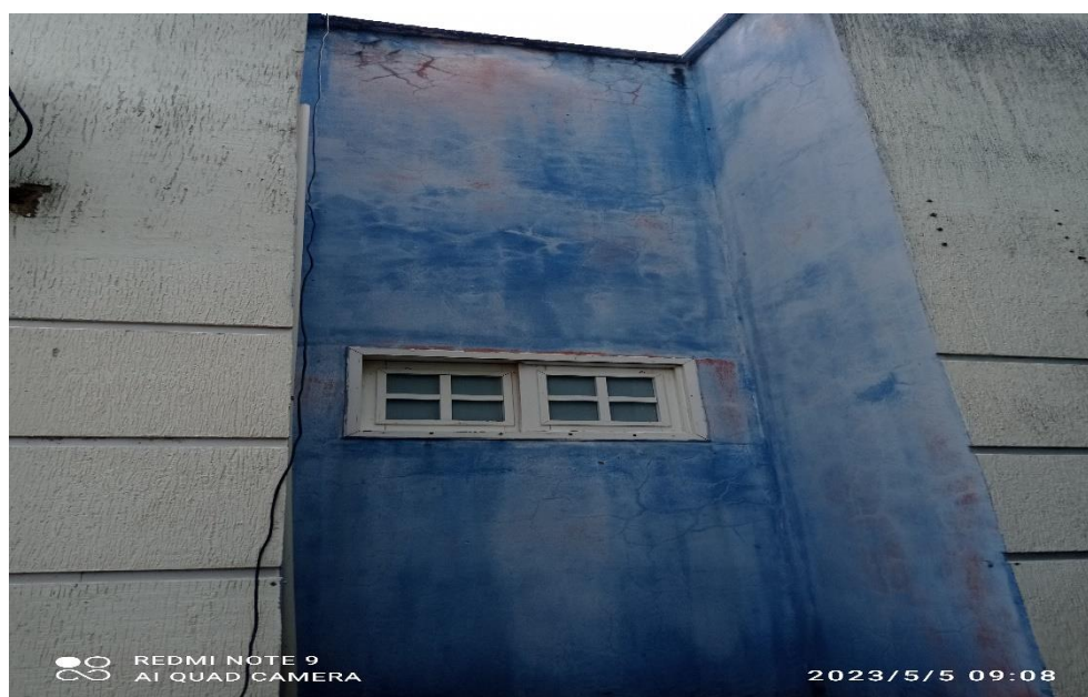
Foto 08 – Parede Externa Lado Direito
