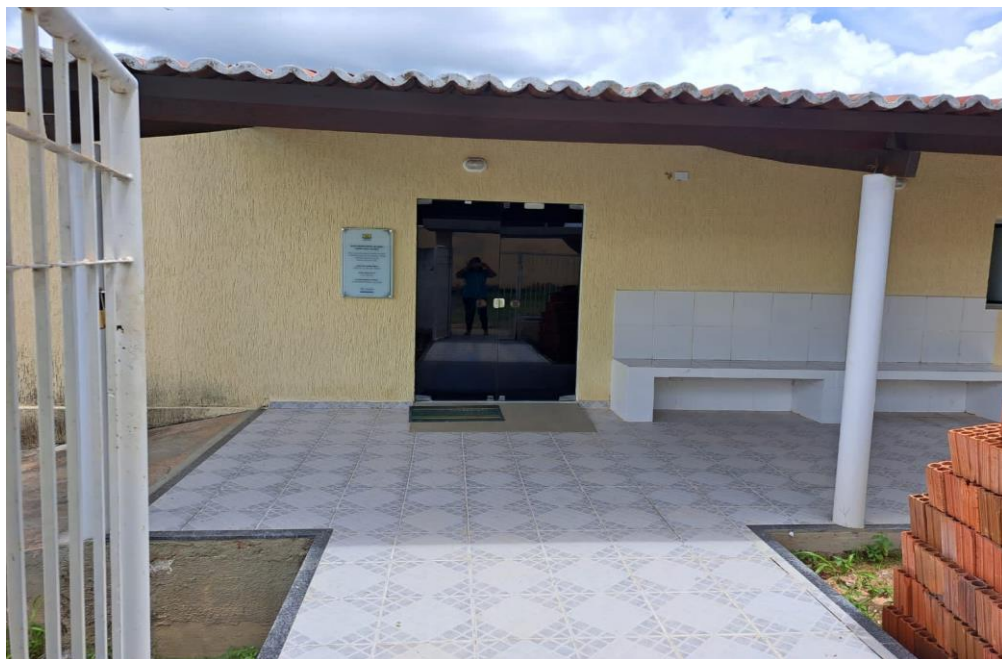
Foto 02: Fachada frontal/ Pórtico
