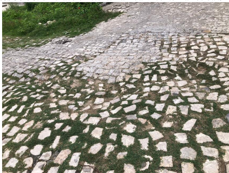
Fotos 38 e 39: Buraco existente na Rua Vicente Barros da Silva
