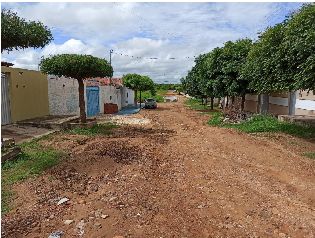
Figura 22: Proximidades da estaca 15 (acervo próprio).
