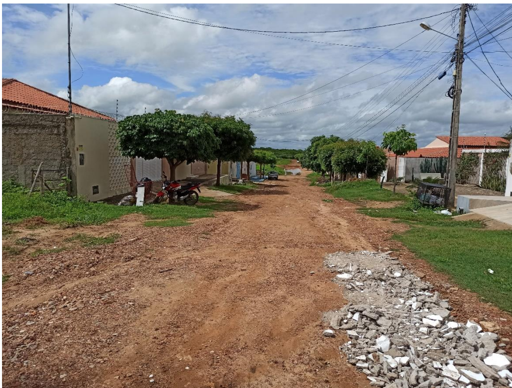
Figura 20: Proximidades da estaca 14 (acervo próprio).
