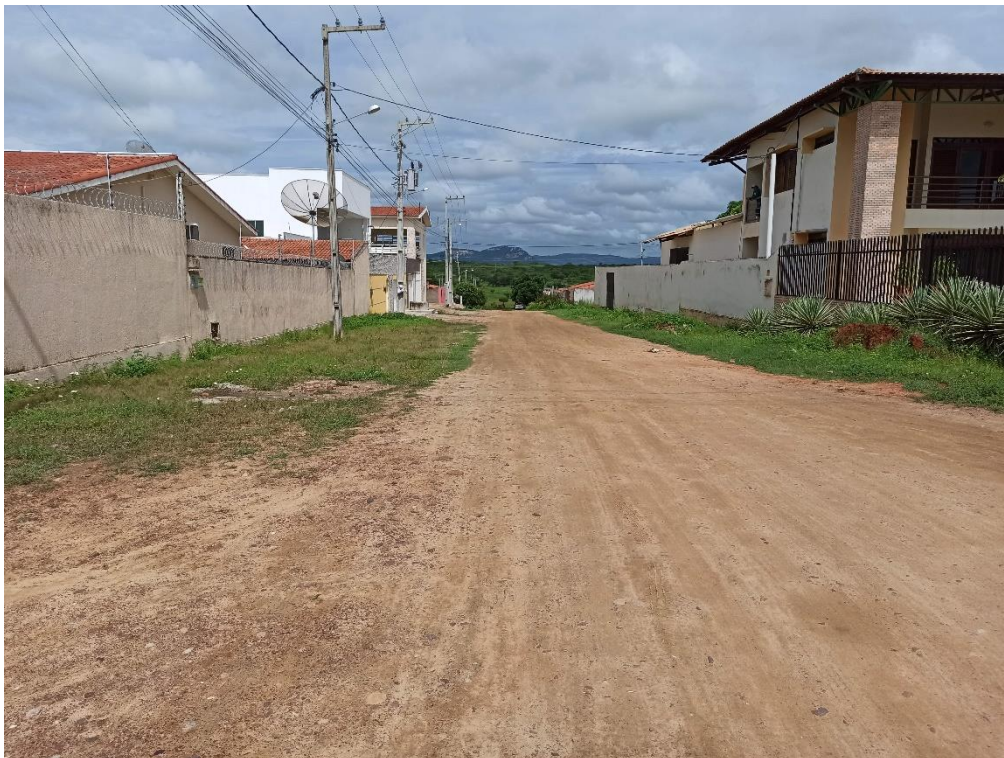
Figuras 14 e 15: Proximidades da estaca 9, visada rua Inglaterra (acervo próprio).
