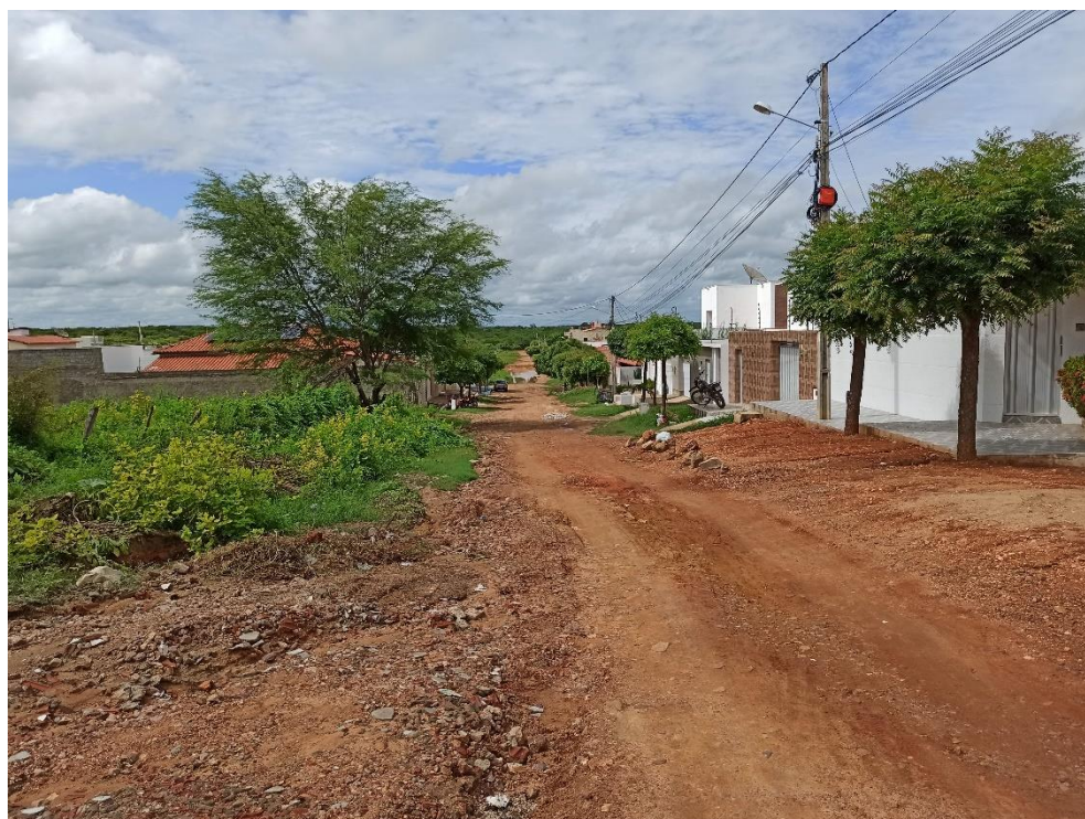
Figura 18: Proximidades da estaca 12 (acervo próprio).
