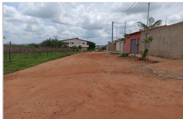
Visão anterior ao trecho D - Trecho da rua Rafael F. de Queiroz Coordenadas UTM 586585E e 9325288N
