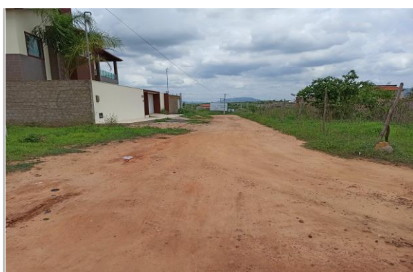
Início TRECHO E - Trecho da rua Rafael Fernandes de Queiroz Coordenadas UTM 586585E e 9325288N
