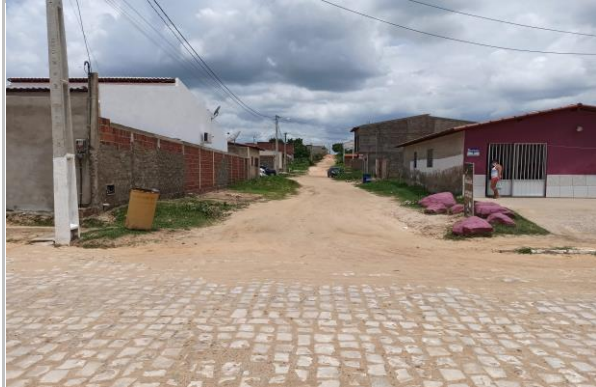
Início TRECHO A - Trecho da rua Rafael Fernandes de Queiroz Coordenadas UTM 586506E e 9324995N
