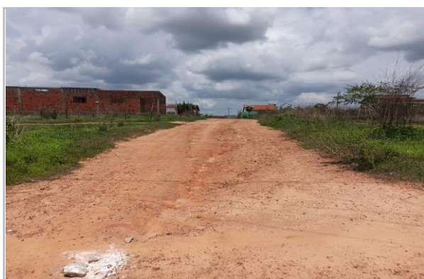
Início TRECHO D - Trecho da rua Urbano Fernandes de Melo Coordenadas UTM 586483E e 9325237N
