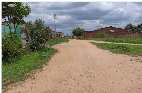
Visão Anterior ao trecho B - Trecho da rua João F. do Nasci. Coodenadas UTM 586493E e 9325305N
