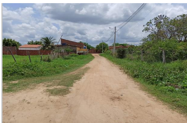
Visão Anterior ao trecho A - Trecho da rua Urbano F. de Melo Coordenadas UTM 586451E e 9325078N
