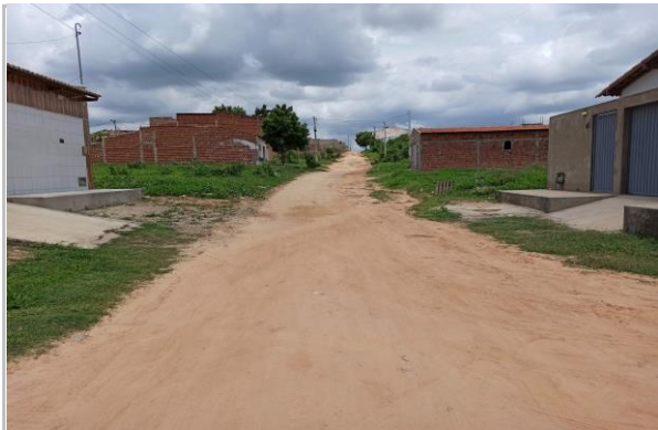
Início TRECHO B - Trecho da rua Rafael Fernandes de Queiroz Coordenadas UTM 586522E e 9325062N
