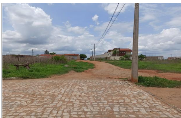
Início TRECHO A - Trecho da rua João F. do Nascimento Coordenadas UTM 586650E e 9325275N
