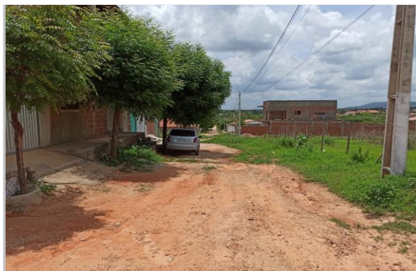
Visão Anterior ao trecho C - Trecho da rua Urbano F. de Melo Coordenadas UTM 586483E e 9325237N
