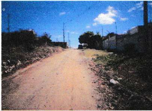
Final TRECHO A - Rua Professora Maria Fernandes - Coordenadas UTM 587559 E e 9322287 S, vista Sul -
