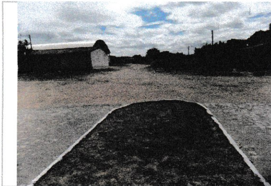
Final TRECHO Nº 04 - Avenida 03 e Final TRECHO Coordenadas UTM 595435 E e 9323086 - Est 13 +
