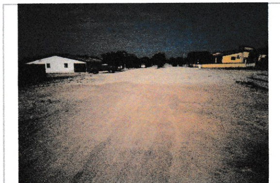
TRECHO Nº 03 - Avenida 02 - Visão Central Coordenadas UTM 595405 E e 9323185 - Est 9 +
