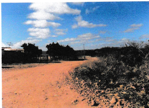
Continuação do Acesso Principal a Comunidade Coordenadas UTM 589864 E e 9320686 S - Est 5 +
