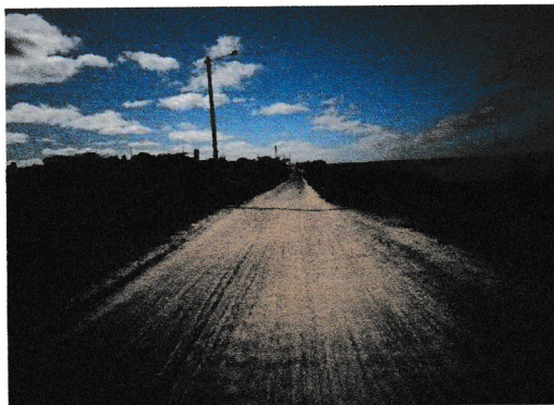
Continuação do Acesso Principal a Comunidade Coordenadas UTM 589949 E e 9320567 S - Est 13
