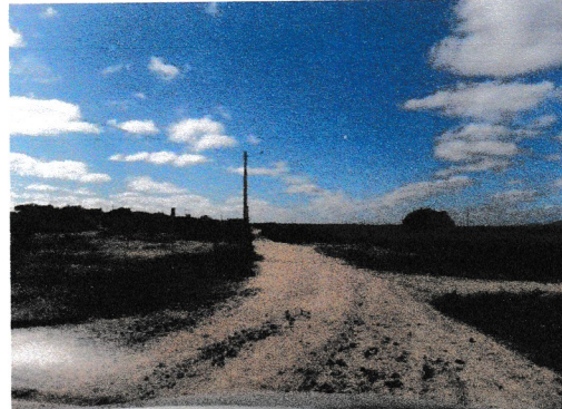
Continuação do Acesso Principal a Comunidade Coordenadas UTM 589885 E e 9320608 S - Est 10
