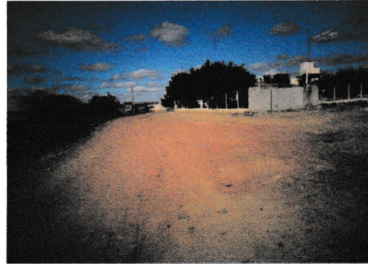
Continuação do Acesso Principal a Comunidade Coordenadas UTM 590504 E e 9320636 S - Est 45,
