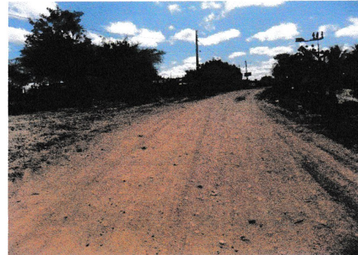
Continuação do Acesso Principal a Comunidade Coordenadas UTM 590321 E e 9320518 S - Est 34
