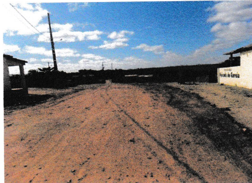
Continuação do Acesso Principal a Comunidade Coordenadas UTM 589809 E e 9320719 S - Est 2 +
