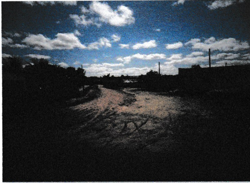
Continuação do Acesso Principal a Comunidade Coordenadas UTM 590350 E e 9320523 S - Est 35
