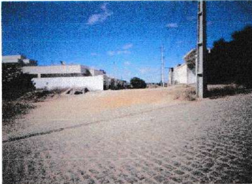
Início TRECHO A - Rua Professora Maria Fernandes - Rua próxima a subestação da COSEERN,
