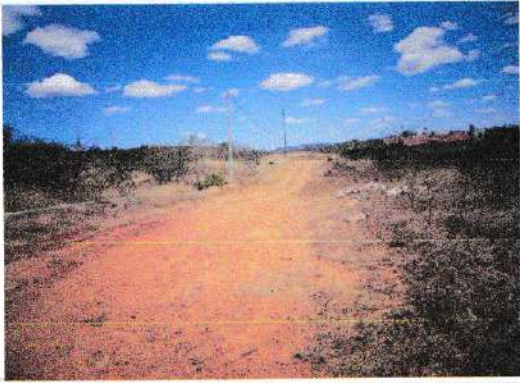
Final TRECHO C - Rua Professora Maria Fernandes - Coordenadas UTM 587558 E e 9322110 S
