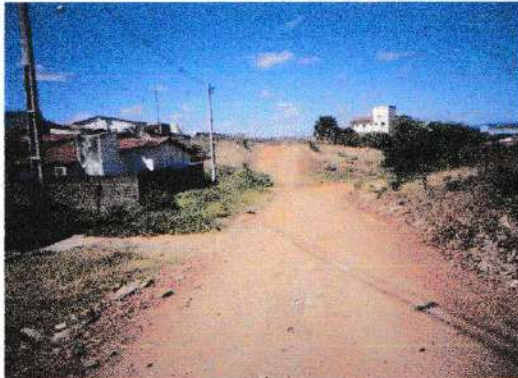
Início TRECHO B - Rua Professora Maria Fernandes - Coordenadas UTM 587559 E e 9322287 S
