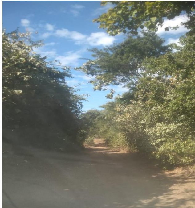
Foto 14: Trecho que necessita de serviço de roço
