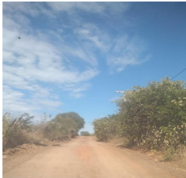
Foto 18: Trecho que necessita de serviço de roço
