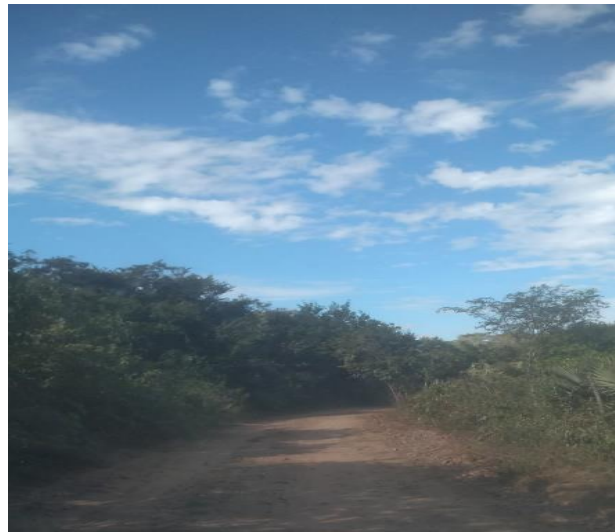
Foto 04: Trecho que necessita de serviço de roço
