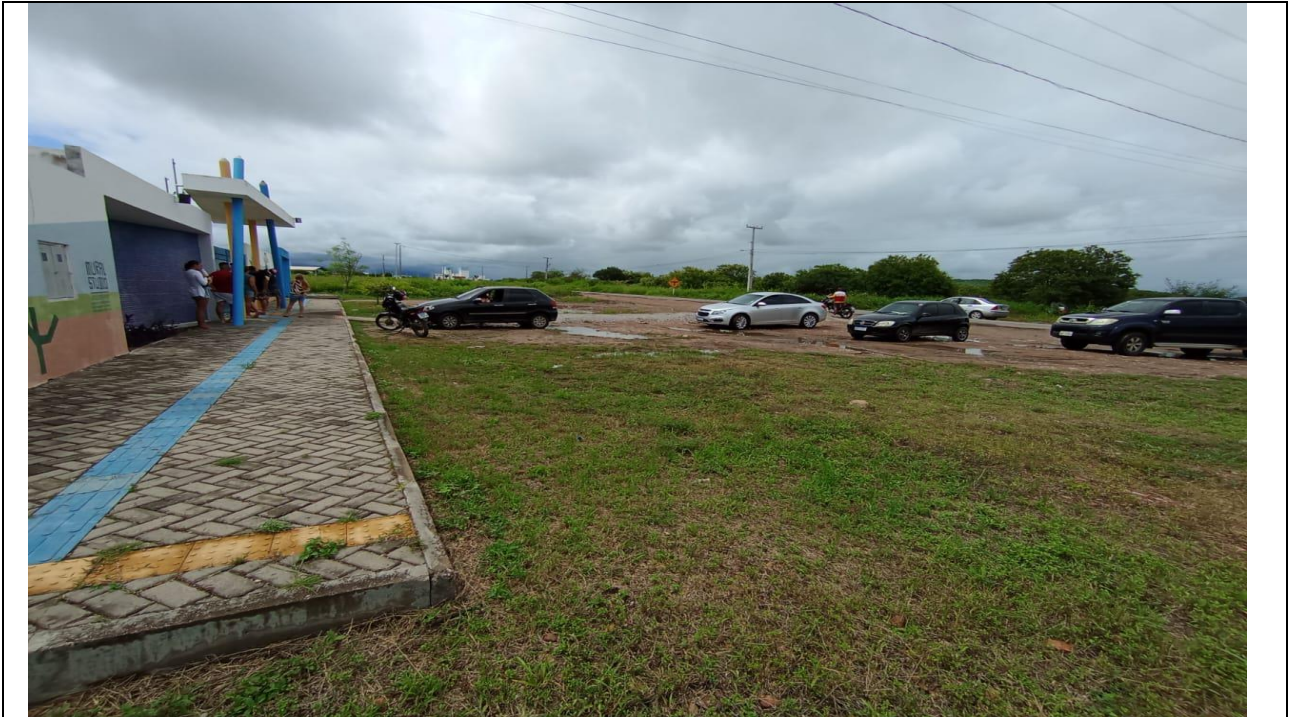
Vista Lateral – Lado Oeste
