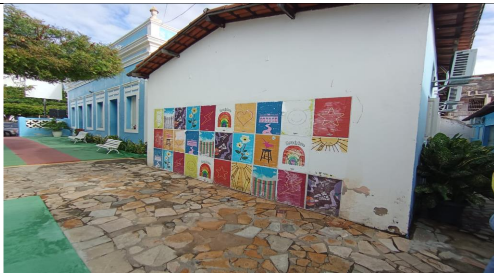
Parte Posterior / Lado Norte: Local onde será feito acessibilidade
