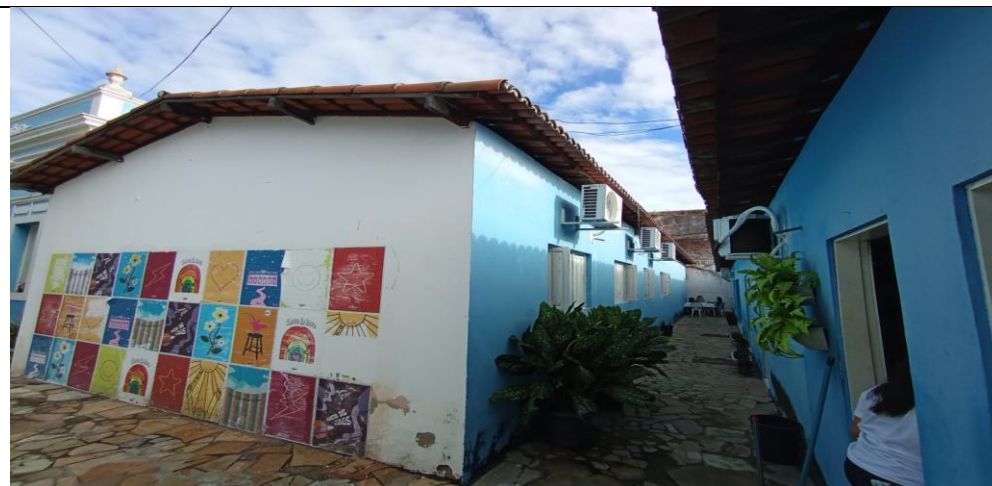
Acesso Leste - Local onde será feito abertura de porta e Acessibilidade
