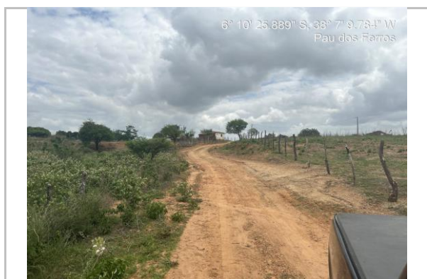
TRECHO JOÃO GATO MACAXEIRA. RE-05 Coordenadas LAT: 6°10'27.85"S, LONG: 38°
