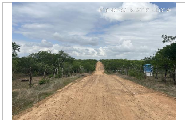
TRECHO DEDÉ DOS CORREIOS. RE-05 Coordenadas LAT: 6° 8'43.05"S, LONG: 38° 8'1.61"O
