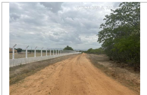
TRECHO LAGOINHA DOS ESTEVÃOS. RE- E-33 Coordenas LAT: 6°7'37.293" S, LONG: 38°14'9.77"
