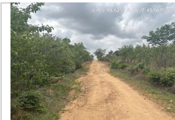
TRECHO ALTO DA CAPA EXTREMA. RE-07 Coordenadas LAT: 6°10'13.72"S, LONG: 38°
