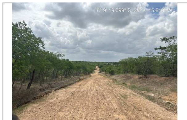
TRECHO SERROTE DE ISRAEL. VANTE-00 Coordenadas LAT: 6°10'13.72"S, LONG: 38°
