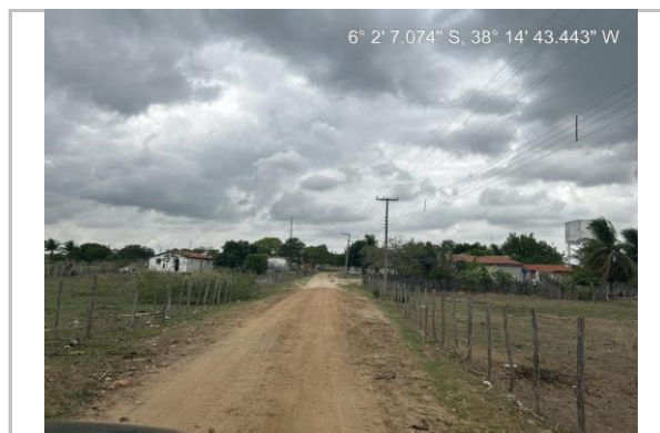
TRECHO AREIA. VANTE- E-24 Coordenas LAT: 6° 2'7.16"S, LONG:
