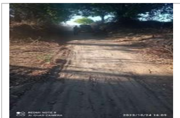
Trecho 01 - EST. - 4+10.552 - Sitio Maniçoba Coordendas 06° 03' 25.3"S 38° 13' 44.0"W
