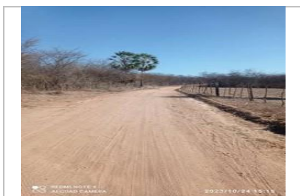
Trecho 01 - EST. - 0+13.009 - Sitio Varzea Nova Coordenas 06° 10' 1.5"S 38° 05' 47.0"W
