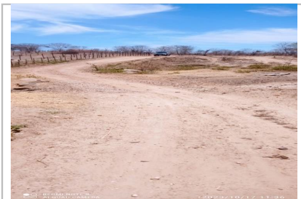
Est. 13+5.837 - Pedra Preta Coordenadas Lat.-6.070584°S Long -38.197395°W
