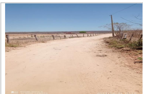
Trecho Inicial - Est. 00 a est. 03 - Santa Tereza Coordendas Lat -6.146298°S Long -38.159008°W
