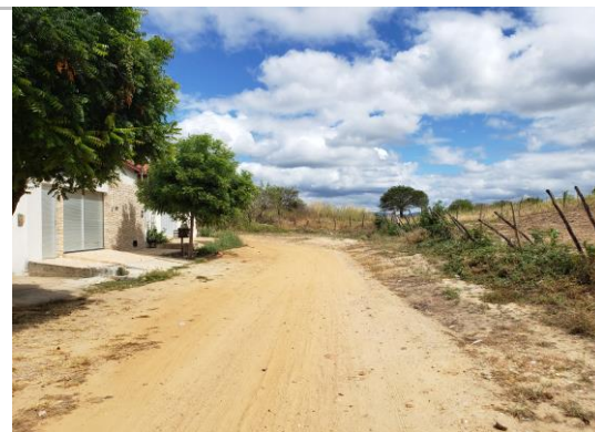
RUA 01 - EST. - 13 Coordenadas UTM 587505.33, 9325564.52, 24M
